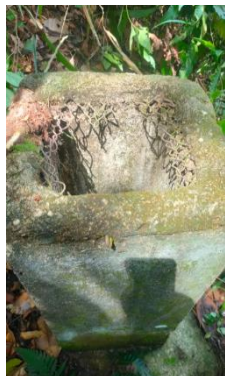
Gambar 15. Salah satu cerobong udara pada Bunker Coa Sako 2 (Sumber : Data TACB Bengkulu Tengah 2024)
