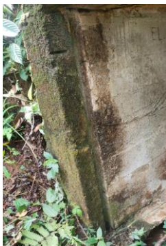
Gambar 9. Sisi kanan pintu Masuk Bunker 2 yang memiliki garis celah untuk menutup lorong dengan pintu. (Sumber: Data Tim TACB Bengkulu Tengah 2024)
