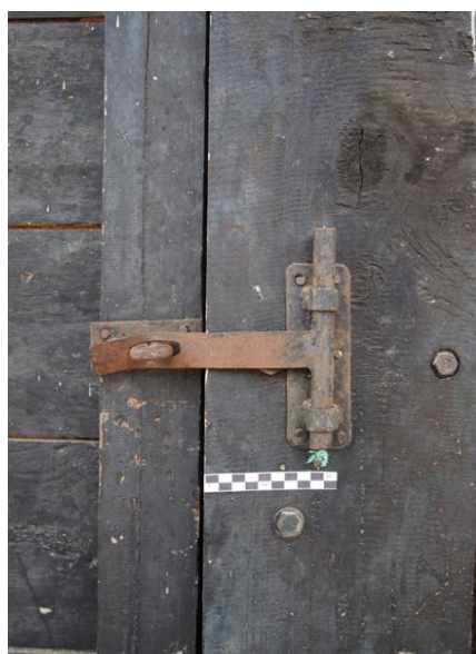
Gambar 9. Bentuk keseluruhan pengait dan knop pengait di pintu bangunan Jail/Penjara Belanda (Sumber: TACB Kab. Kaur, 20 September 2024)
